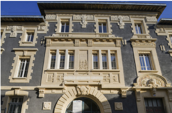
• Façade rénovée et ravalée
