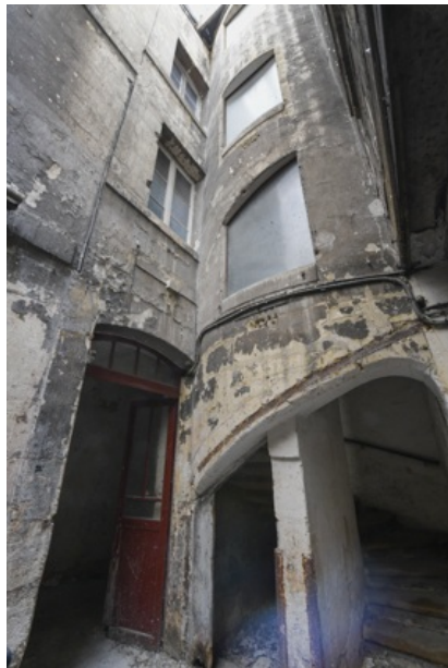
La tour d'escalier de 1592 sera rénovée
