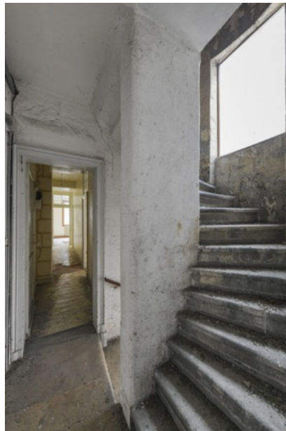
Vue du 1er étage avant travaux
