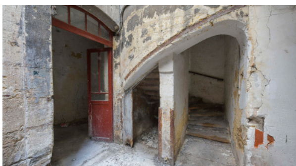
• Vue de la tour d'escalier et cour Avant
