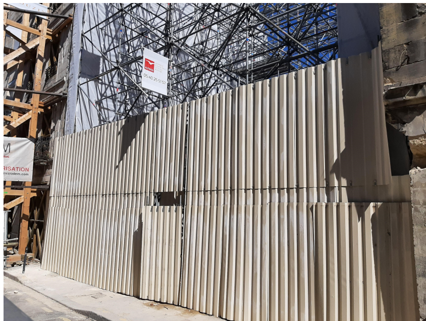
Installation de la palissade et des échafaudages de protection contre les façades des 22 et 28 rue Planterose
