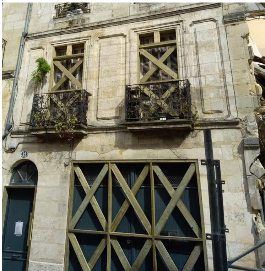
Etrépillonnements réalisés sur la façade du 22 rue Planterose mardi 22 juin
