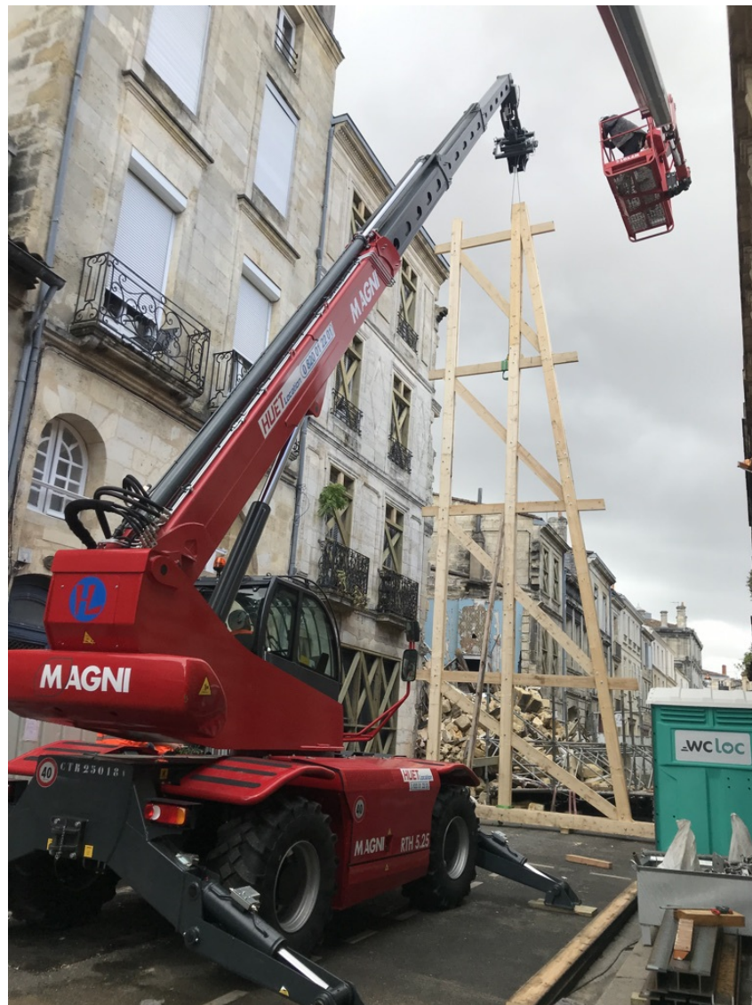
Installation en cours du chevalet en bois pour soutenir la façade du 22 rue Planterose
