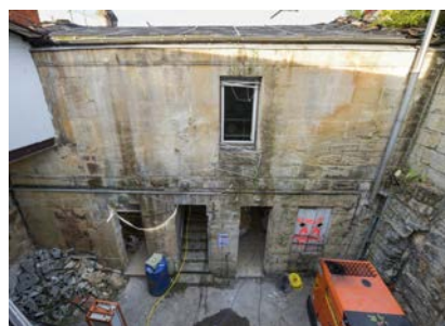
Vue de la parcelle arrière avant travaux
