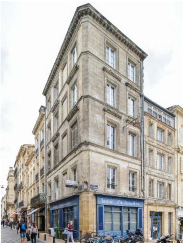
• Vue extérieure angle rue des Ayres Avant travaux
