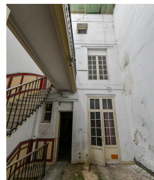
• n°78 avant travaux
