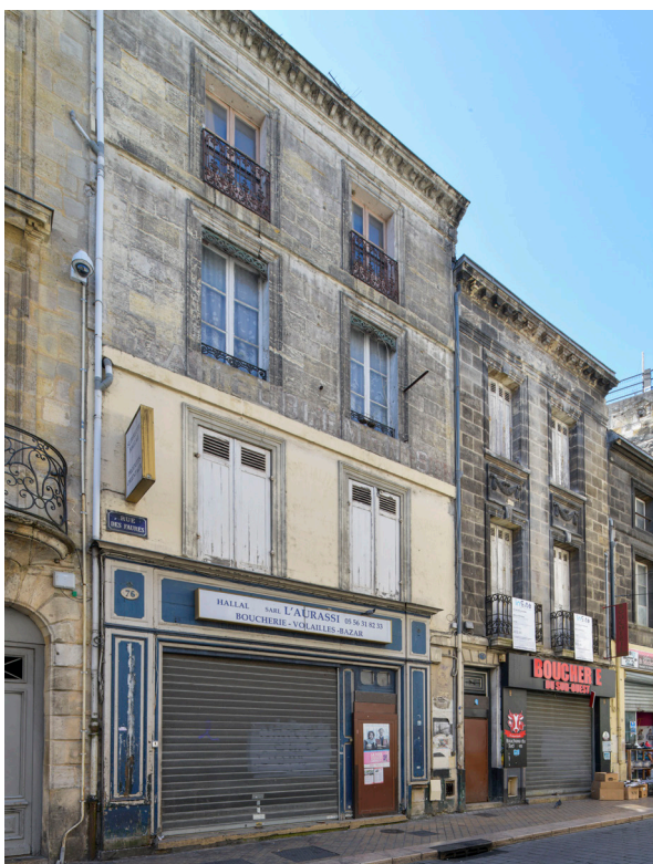
• Vue façades 76 et 78 rue des Faures
