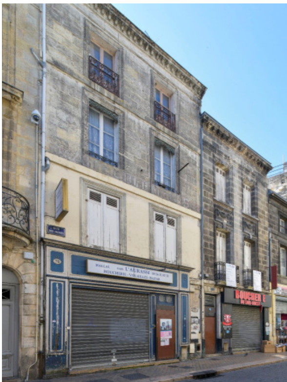
• Vue façades 76 et 78 rue des Faures
