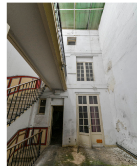
• n°78 avant travaux
