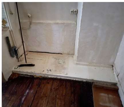
Purge en so/ Remplacement des menuiseries PVC
