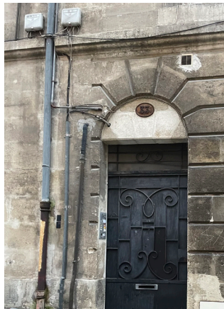
Purge du remplissage de l'arc, selon contraintes plancher haut/ Purge des réseaux sauvages
