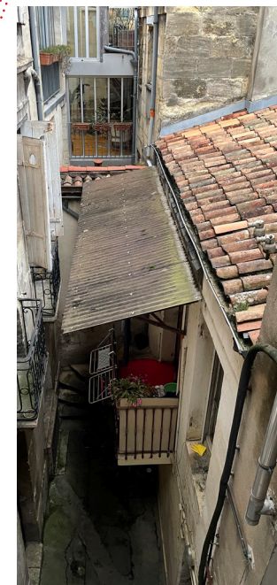
Dépose de l'escalier pierre, du balcon et de l'onduline sur cour principale/ Purge de tous les réseaux sauvages (d'évacuations, électriques, etc)
