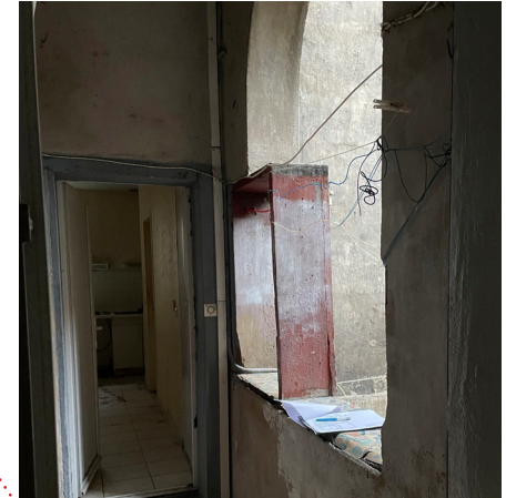
Restitution de l'arc en façade sur cage d'escalier commune
