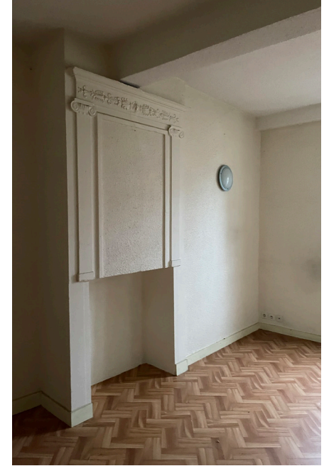
Purge du conduit et manteau de cheminée/ Contrôle des ancrages (si pas d'abaissement du plancher haut)
