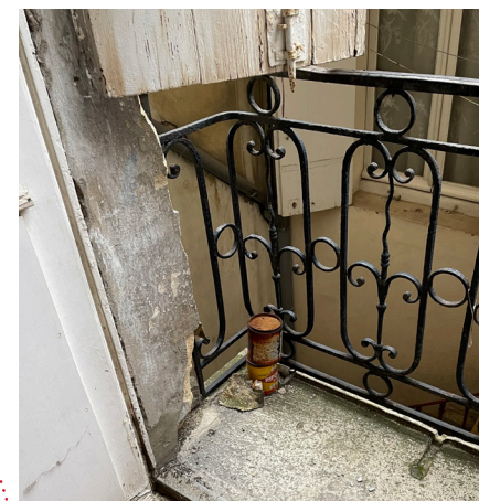
Réparation des épaufrures en tableaux
