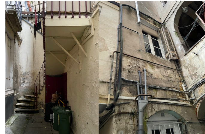
Dépose de l'escalier pierre, du balcon et de l'onduline sur cour principale/ Purge de tous les réseaux sauvages (d'évacuations, électriques, etc)
