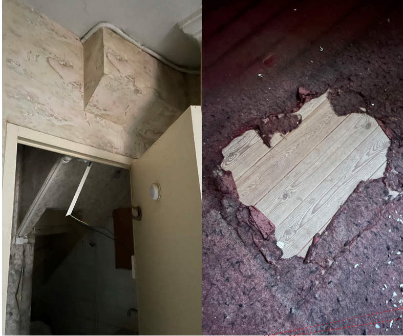
Suppression de l'escalier d'accès aux combles (trappe pour futur accès technique)/ Récupération parquet en sol
