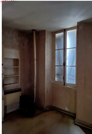
Adapter hauteur de menuiserie, pour maintien d'usage après isolation de la toiture/ Restituer ancienne ouverture sur cour
