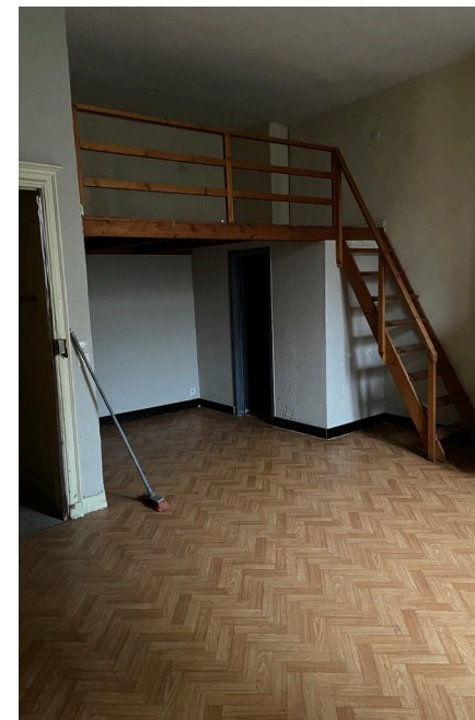
Purge de la mezzanine pour restitution du volume d'origine
