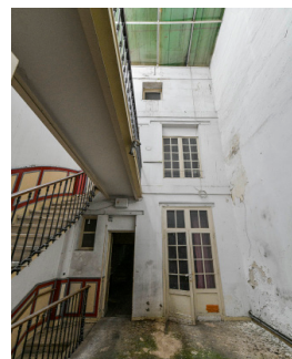
• n°78 avant travaux
