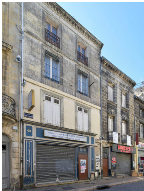
• Vue façades 76 et 78 rue des Faures
