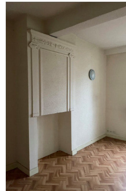
Purge du conduit et manteau de cheminée/ Contrôle des ancrages (si pas d'abaissement du plancher haut)
