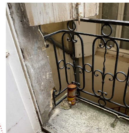
Réparation des épaufrures en tableaux
