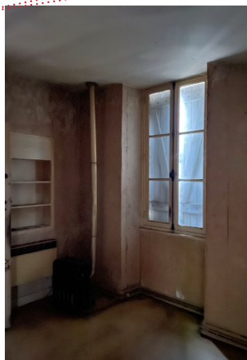
Adapter hauteur de menuiserie, pour maintien d'usage après isolation de la toiture/ Restituer ancienne ouverture sur cour
