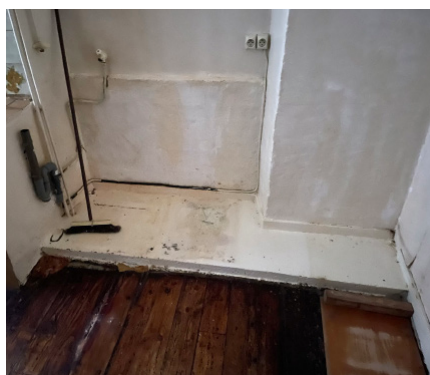
Purge en so/ Remplacement des menuiseries PVC
