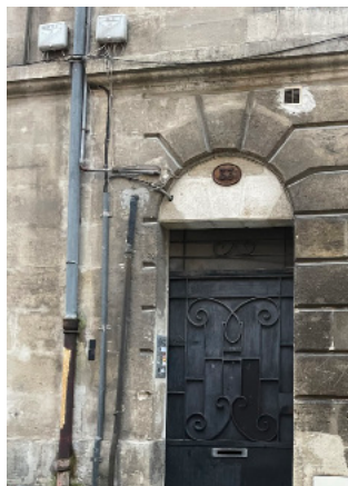
Purge du remplissage de l'arc, selon contraintes plancher haut/ Purge des réseaux sauvages
