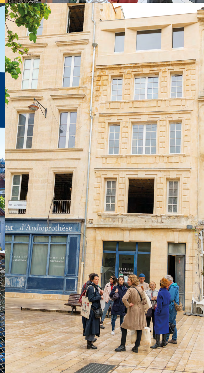
Visite de chantier ouverte au public, place Lafargue/rue des Ayres, à Bordeaux, à la découverte du projet de réhabilitation qui a permis la création de 8 nouveaux logements sociaux ainsi que la rénovation d'un local d'activités, gérés par inCité.
